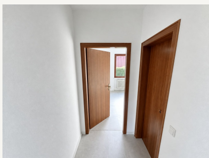
22 Flur mit Holztüren
